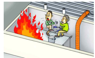
〈도금조 보수작업 중 화재로 화상〉
