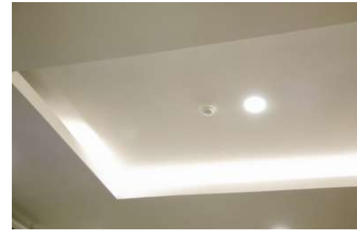
우물천장 설치 예시
