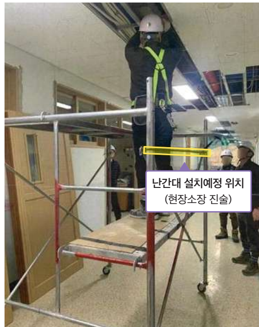
설치했어야 하는 안전난간 위치
